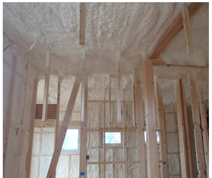
外断熱材に硬質ウレタンフォーム（アクアフォーム）を吹き付け
