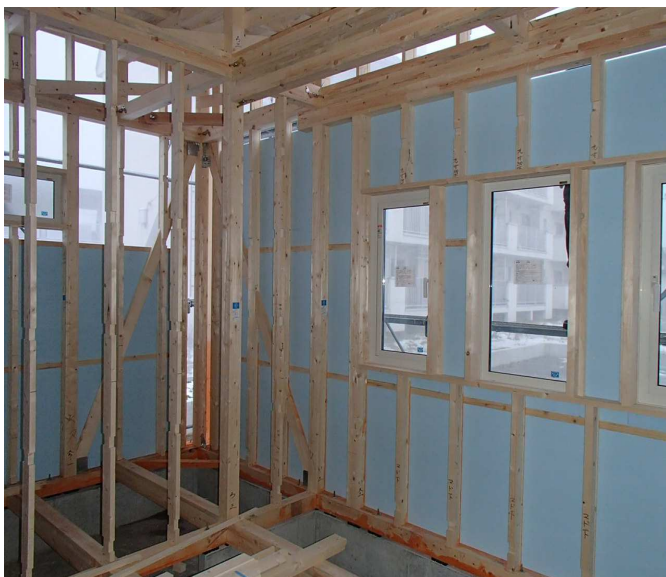
外断熱材・押出スチレンフォーム3種を内側から撮影
